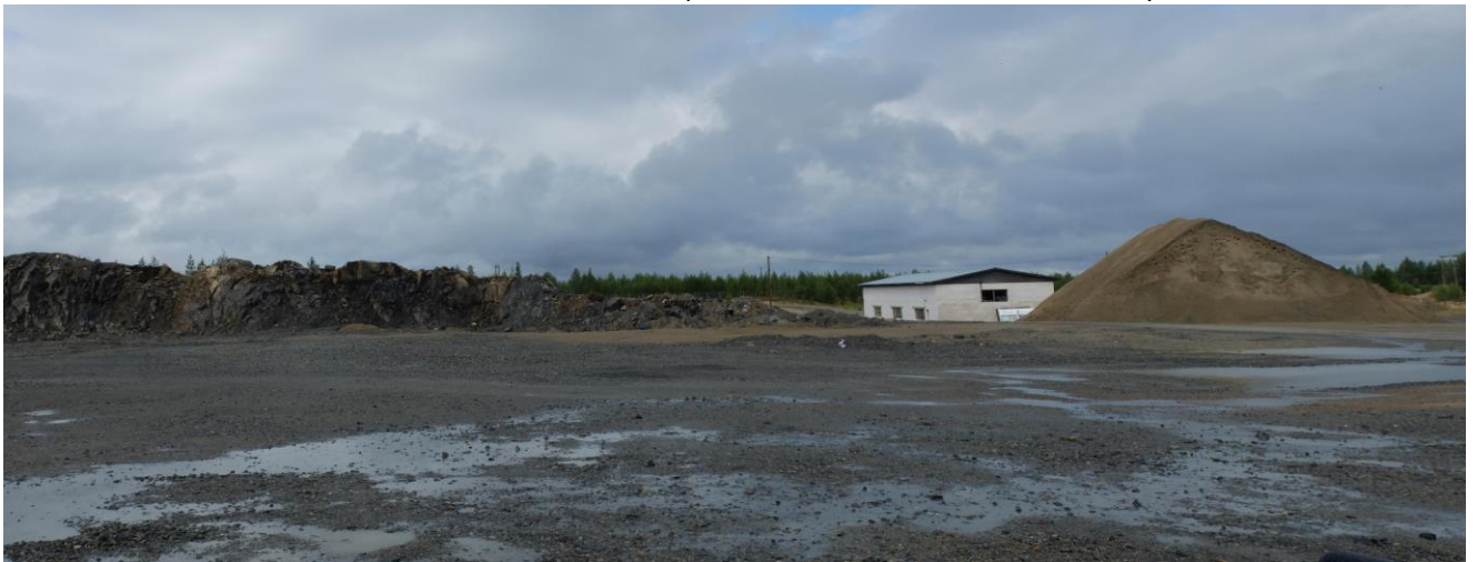
Louhinta aloitetaan kuvan vasemman reunan kapean kallion poistolla. Taustalla konehalli (Kuva: Kimmo Mustonen 14.7.2020)
