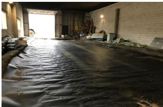
Hallin pohjan eristystä
