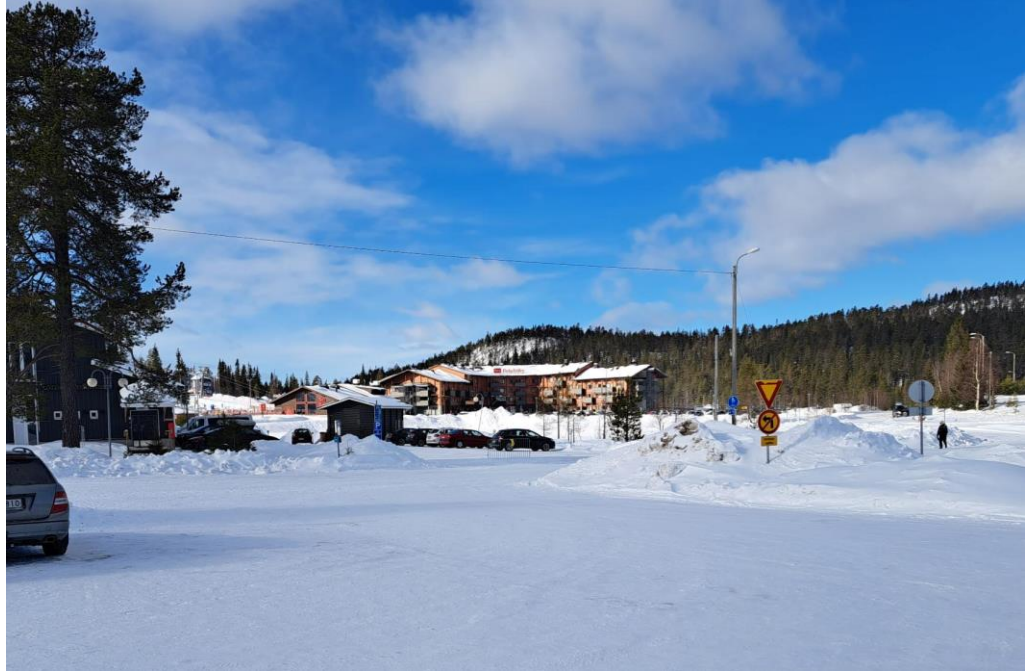
Näkymä suunnittelualueelle Jussinkujan vieriseltä pysäköintialueelta. Kuvassa oleva korkeampi rakennus on vuonna 2019 valmistunut RukaValley-niminen hotelli. Matalampi rakennus on SkiBistro-ravintola.
