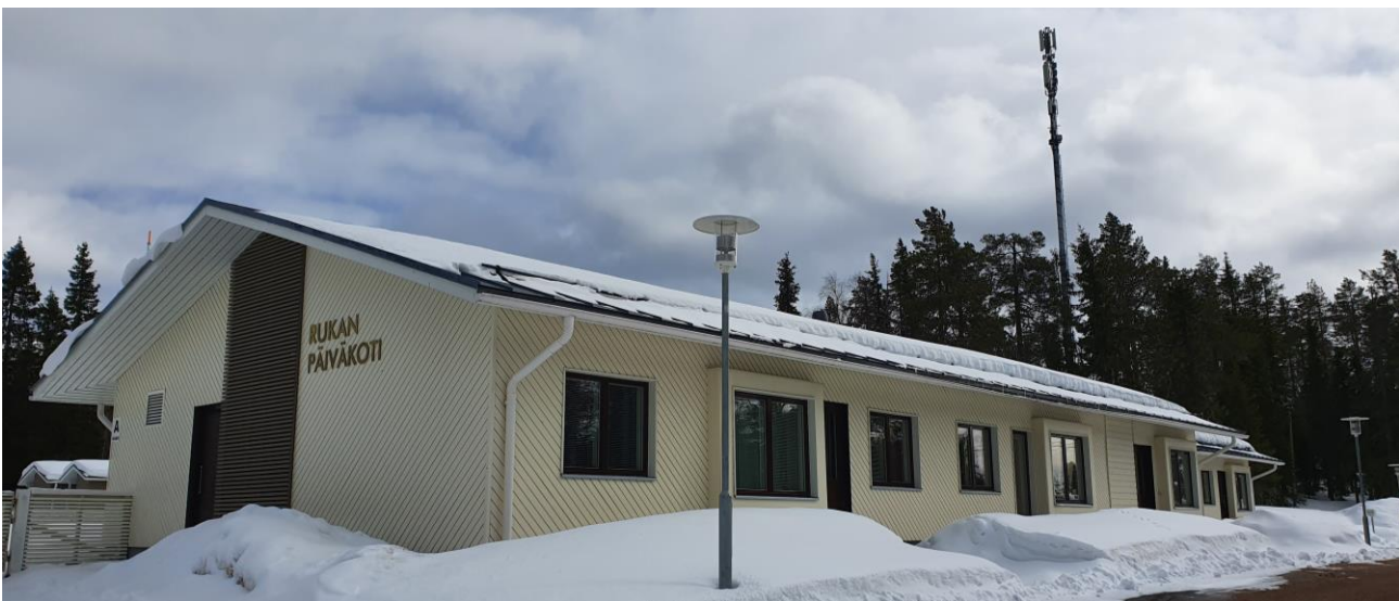
Kuva 39. Rukan päiväkoti sijaitsee Uunikulman alueella.
