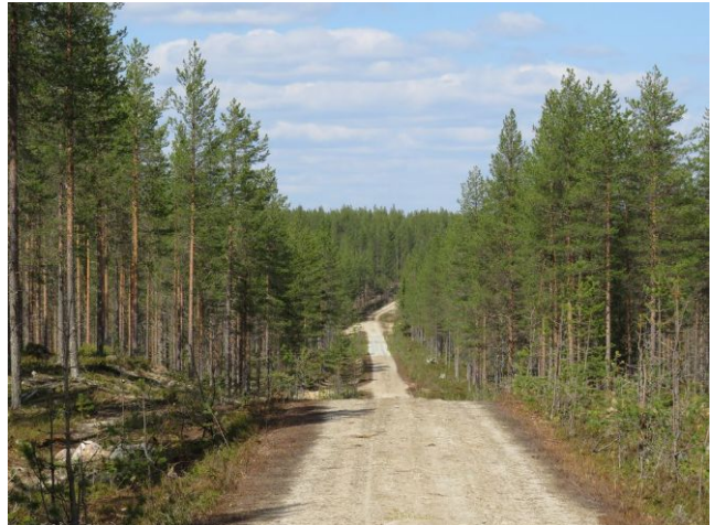
23. Kaapelilinjausta Kurjenjoen pohjoispuolella.
