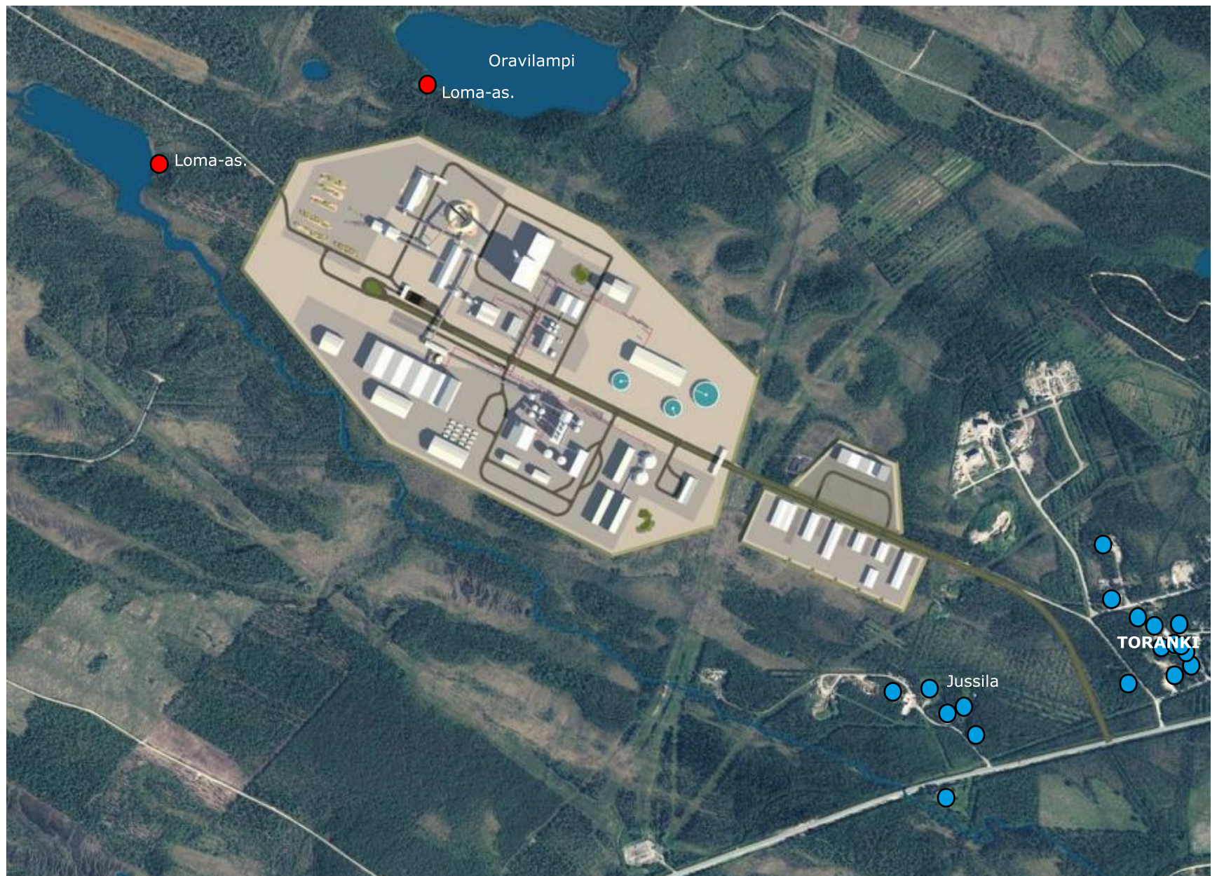
Kuva 3.1. Suunnittelualue ja lähimmät asuinrakennukset sinisin ja loma-asunnot punaisin pistein. Oravilammen loma-asunto mahdollisesti hylätty.
