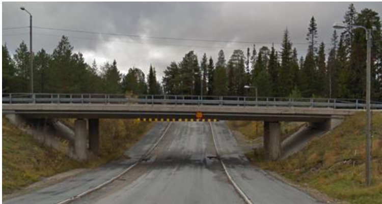
Valtatien 5 Kesäjärventien alikulku (GoogleMaps, haettu 12.2.2021). Kevyen liikenteen yhteys on toteutettu jalkakäytävänä tien molemmin puolin.
