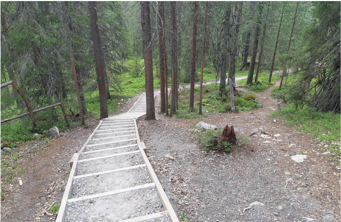
Kuva 42. Valtavaaralla olevat maaportaat. Retkeilyrakenteilla ohjataan kävijöiden kulkua ja ehkäistään maaston kulumista, kuten uusien polkujen syntymistä tai jo olemassa olevien polkujen laajenemista hallitsemattomasti.
