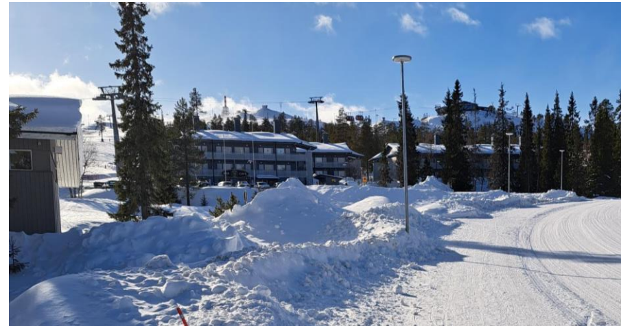
Ahon Jussintie, taustalla 2000-luvun alkupuolella valmistuneet majoitusrakennukset
